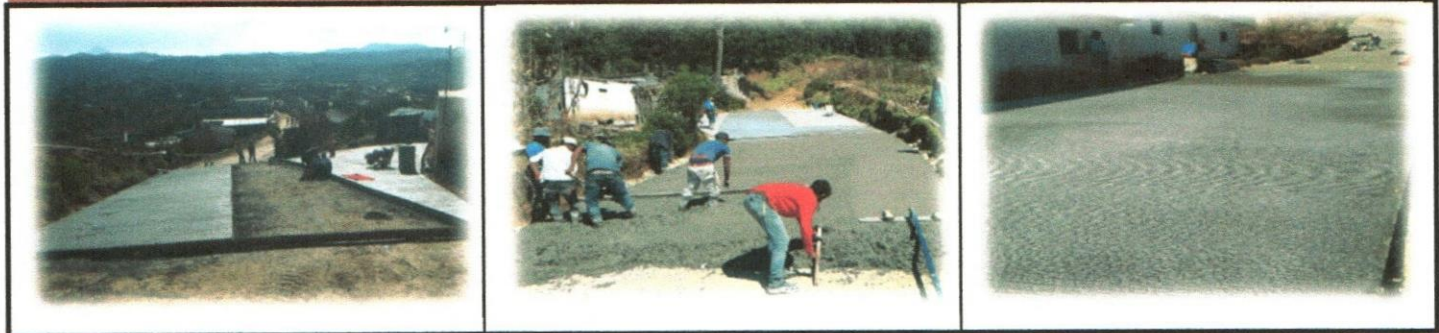
MEJORAMIENTO CAMINO RURAL, PARAJE CHIRRENOX, ALDEA CHIRRENOX, SAN FRANCISCO EL ALTO, TOTONICAPAN
