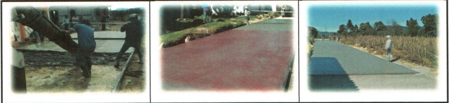
MEJORAMIENTO CAMINO RURAL, PARAJE CHI-MACARIO SEGUNDO, ALDEA RANCHO DE TEJA, SAN FRANCISCO EL ALTO, TOTONICAPAN
