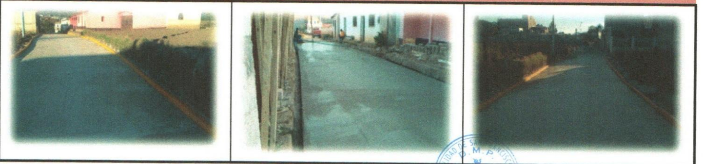
MEJORAMIENTO CAMINO RURAL, CAMINO REAL SECTOR II, ALDEA SACMIXIT, SAN FRANCISCO EL ALTO, TOTONICAPAN
