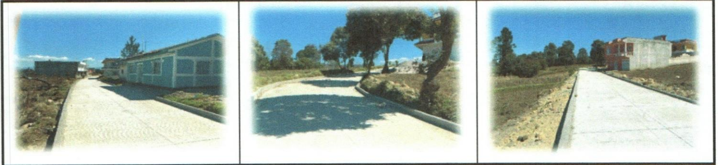
20. MEJORAMIENTO CAMINO RURAL, PARAJE CHI-MACARIO SEGUNDO, ALDEA RANCHO DE TEJA, SAN FRANCISCO EL ALTO, TOTONICAPAN
