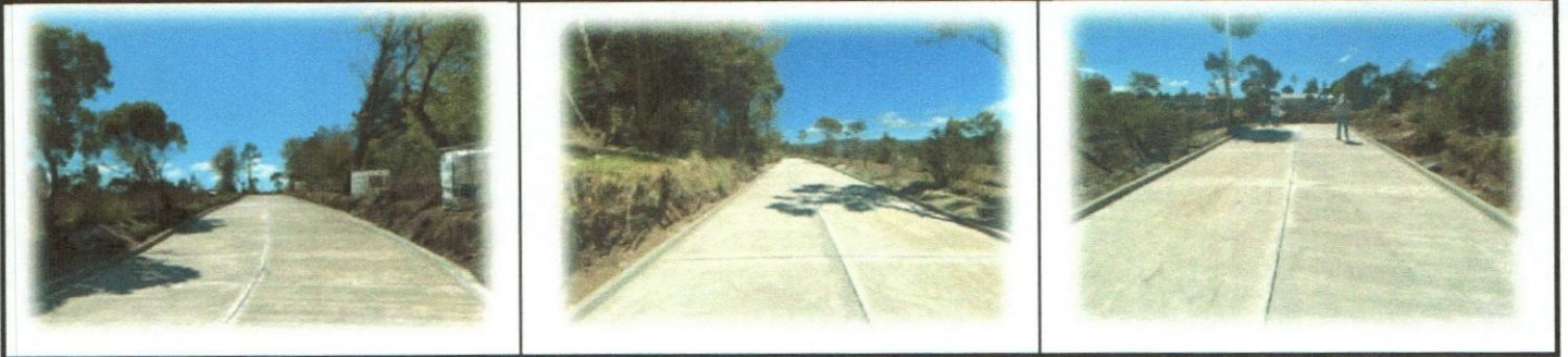
19. MEJORAMIENTO CAMINO RURAL, PARAJE CHIMACAR - PATZULCAN, ALDEA SAN ANTONIO SIJA, SAN FRANCISCO EL ALTO, TOTONICAPAN
