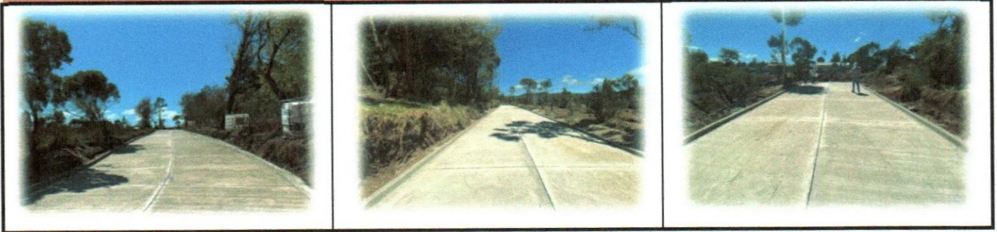
19. MEJORAMIENTO CAMINO RURAL, PARAJE CHIMACAR - PATZULCAN, ALDEA SAN ANTONIO SIJA, SAN FRANCISCO EL ALTO, TOTONICAPAN
