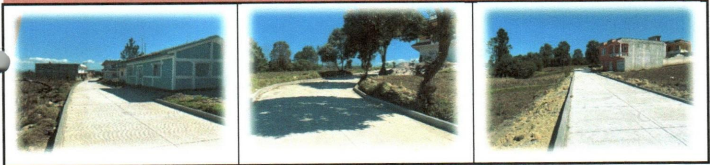
20. MEJORAMIENTO CAMINO RURAL, PARAJE CHI-MACARIO SEGUNDO, ALDEA RANCHO DE TEJA, SAN FRANCISCO EL ALTO, TOTONICAPAN
