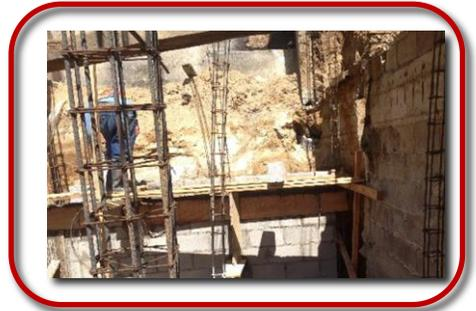
EL PROYECTO SE REALIZO CON LA DEMOLICION DE LA COPNSTRUCCION EXISTENTE, SE PROCEDIO A RETIRAR EL MATERIAL RESULTANTE, LOS TRABAJOS DE ZANJEJO, LA ARMADURA DE LAS ZAPATAS , LAS SOLERAS Y LAS COLUMNAS SE REALIZARON CONFORME A LAS ESPECIFICACIONES Y DETALLES EN PLANOS, EL LEVANTADO DE MURO SE OBSRVA QUE SE ENCUENTRA A PLOMO Y LAS ARISTAS
