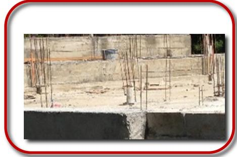
SE ENCOFRO LA LOSA Y EL ARMADO SE REALIZO CONFORME A LA PLANIFICACION, SE DESENCOFRO A LOS VEINTE DIAS DE LA FUNDICION, LOS ACABADOS DE LOS MUROS SE REALIZAN DE UNA FORMA TECNICA Y EL CONTRAPISO DE LA CONSTRUCCION SE REALIZO PARA QUE SEA EL SOPORTE DE PISO Y EVIRA CON ELLO INPERFECCIONES EN LA COLOCACION DEL MISMO. EL AVANCE FISICO DE LA
