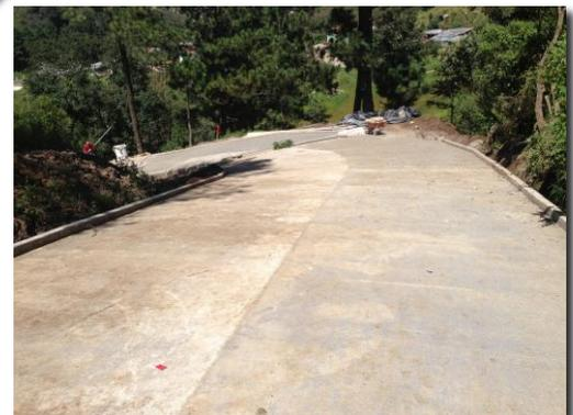
En el proyecto se observó la conformación de la base del camino con material selecto, la compactación, además de ello la fundición de bordillo con resistencia 2,500 psi y el refuerzo con hierro de 3/8" grado 75 como se solicita en las especificaciones técnicas, la carpeta de rodadura se fundió con un espesor de 0.20 mts y resistencia 4,000 PSI, este proyecto lleva un avance físico de
