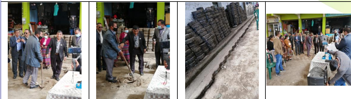
MEJORAMIENTO CAMINO RURAL, CAMINO CENTRAL CALLE INDEPENDENCIA, ALDEA CHIVARRETO, SAN FRANCISCO EL ALTO, TOTONICAPAN
