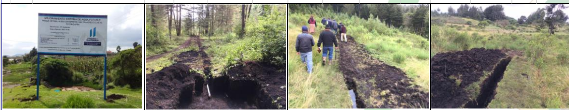
MEJORAMIENTO SISTEMA DE AGUA POTABLE, XETENA ALDEA CHIVARRETO, SAN FRANCISCO EL ALTO, TOTONICAPAN
