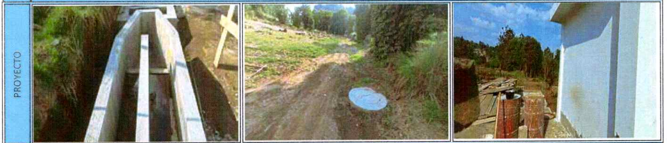
8 CONSTRUCCION SISTEMA DE ALCANTARILLADO SANITARIO , PARAJE PACOTQUIK, PALEMOP ZONA 4, SAN FRANCISCO EL ALTO, TOTONICAPAN
