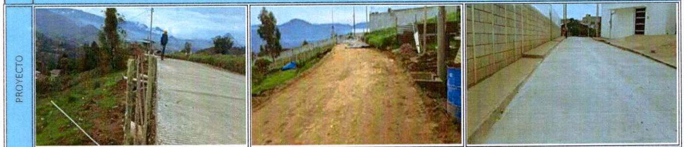
10 MEJORAMIENTO CALLE PARAJE XEGUA PASUC, BARRIO XOLVE ZONA 2 SAN FRANCISCO EL ALTO, TOTONICAPAN
