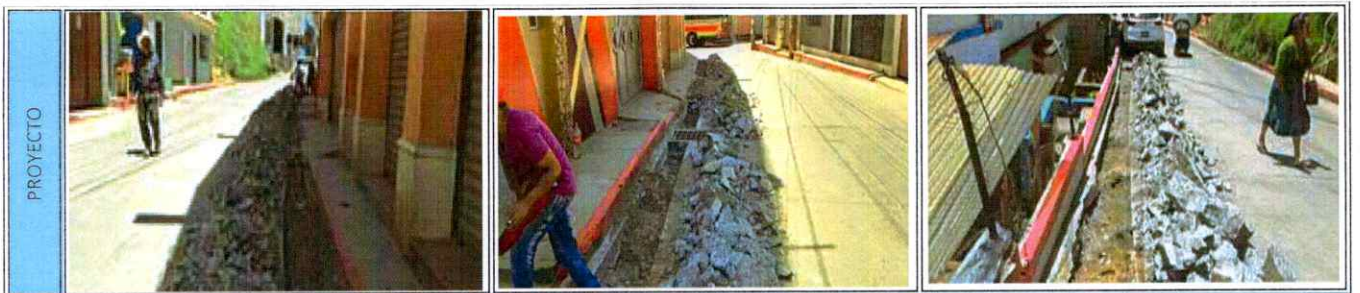
7 CONSTRUCCION SISTEMA DE ALCANTARILLADO SANITARIO , PARAJE XOLCORRAL Y CHIGARCIA, ALDEA SAN ANTONIO SIJA, SAN FRANCISCO EL ALTO, TOTONICAPAN
