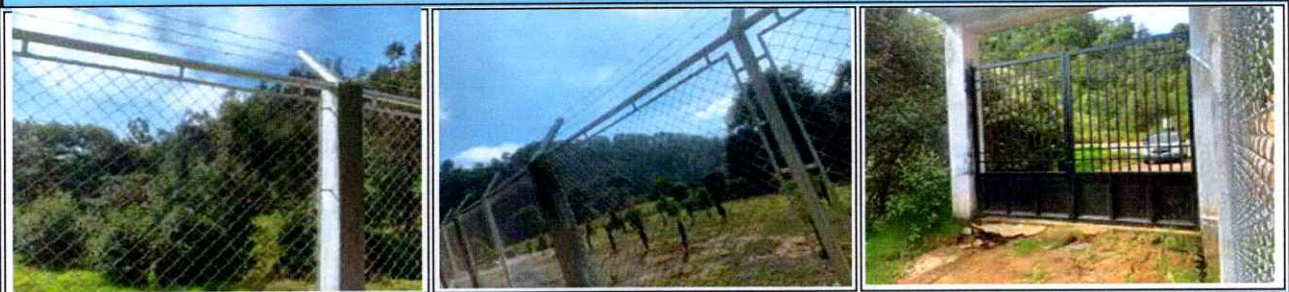
AMPLIACION ESCUELA PRIMARIA , PARAJE LOS DURAZNALES, ALDEA SAQUICOL, SAN FRANCISCO EL ALTO, TOTONICAPAN
