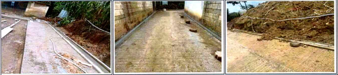
CONSTRUCCION MURO PERIMETRAL PARA LA CONTINUACION DEL MEJORAMIENTO DEL CEMENTERIO, ALDEA SACMIXIT SAN FRANCISCO EL ALTO
