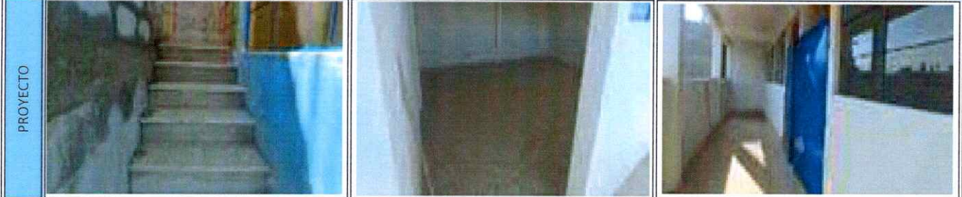
15 MEJORAMIENTO ESCUELA PRIMARIA OFICIAL RURAL MIXTA, SECTOR 1, ZONA 2, BARRIO CHUISIGUAN SAN FRANCISCO EL ALTO, TOTONICAPAN
