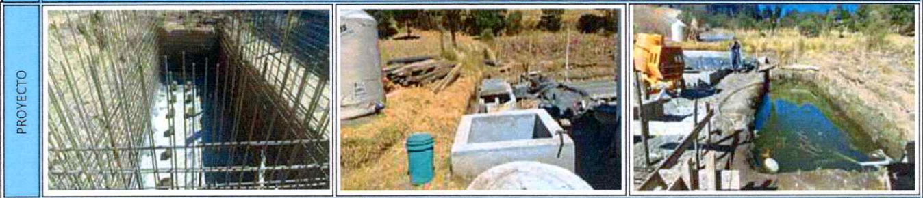
18 CONSTRUCCION SISTEMA DE ALCANTARILLADO SANITARIO SECTOR CHITOCHE, PALEMOP ZONA 4 SAN FRANCISCO EL ALTO, TOTONICAPAN
