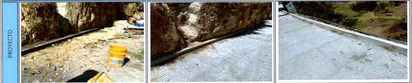
38 MEJORAMIENTO CAMINO RURAL , SECTOR CHOTINTIN, ALDEA CHIVARRETO, SAN FRANCISCO EL ALTO, TOTONICAPAN
