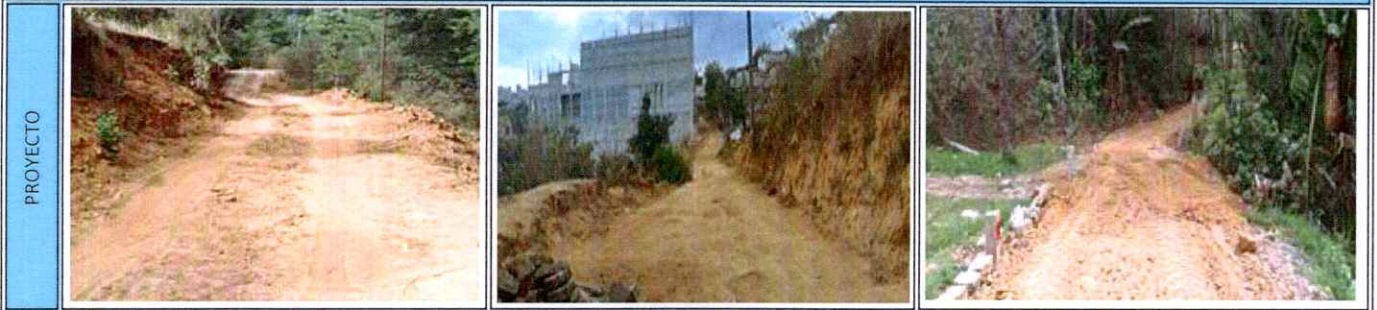
34 MEJORAMIENTO CALLE 1ERA. CALLE ZONA 5, BARRIO CHUISIGUAN SAN FRANCISCO EL ALTO, TOTONICAPAN
