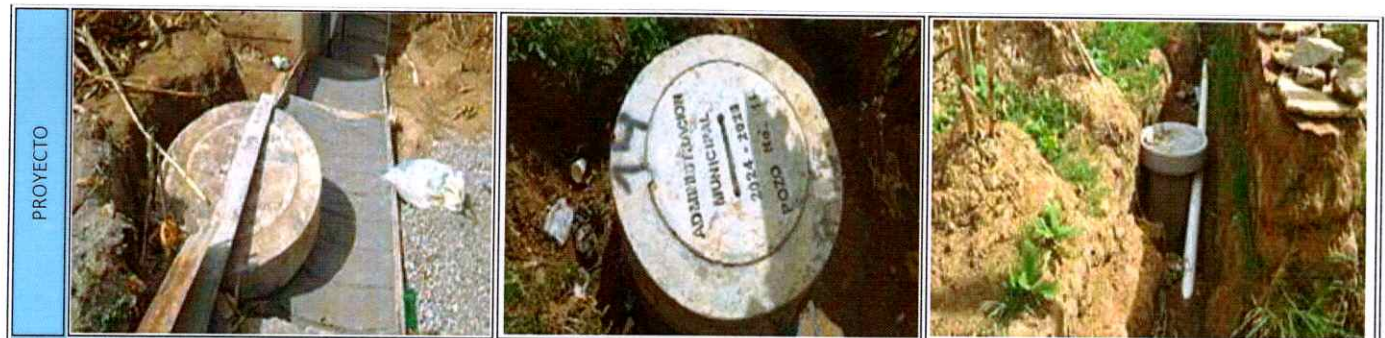
14 AMPLIACION ESCUELA PREPRIMARIA , ALDEA TACAALVE, SAN FRANCISCO EL ALTO, TOTONICAPAN
