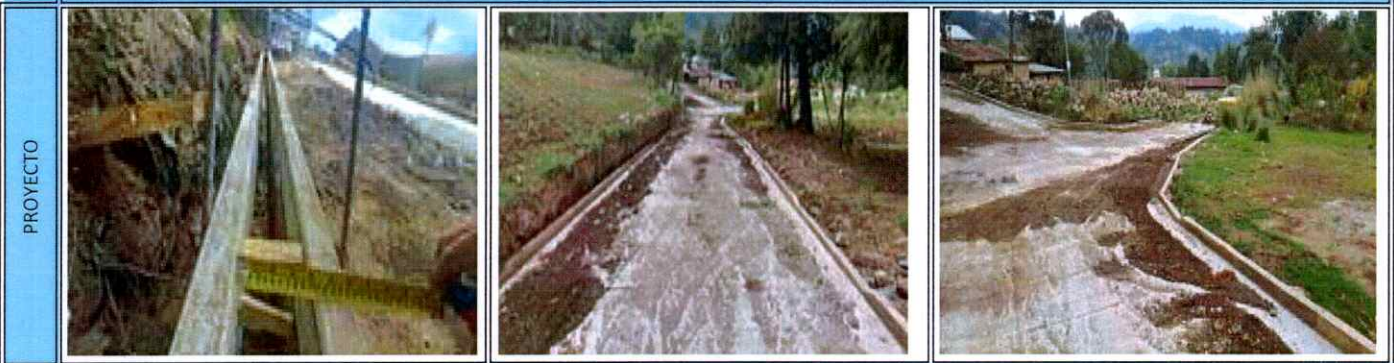
22 MEJORAMIENTO CAMINO RURAL PARAJE XEHAJ, ALDEA CHIRRENOX SAN FRANCISCO EL ALTO, TOTONICAPAN
