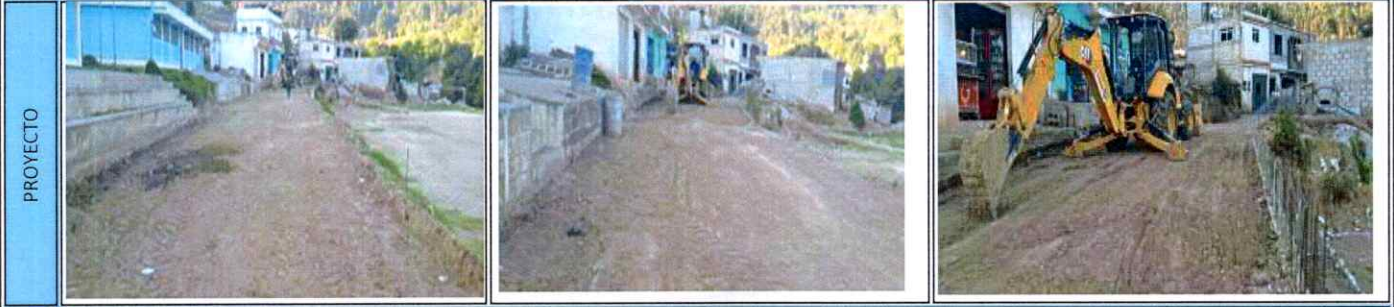
24 MEJORAMIENTO CALLE 2DA. CALLE ZONA 2, BARRIO CHUISIGUAN, SAN FRANCISCO EL ALTO, TOTONICAPAN
