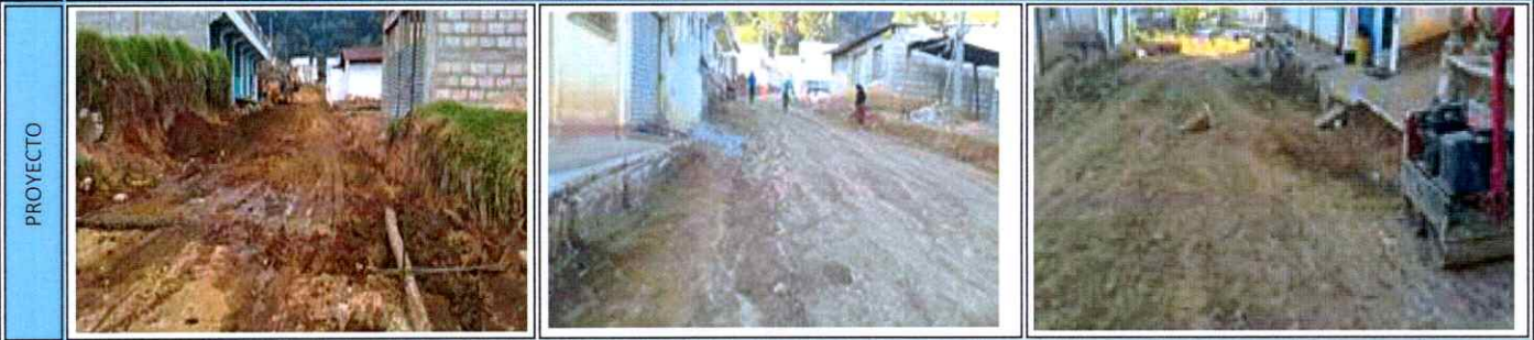
23 MEJORAMIENTO CAMINO RURAL SECTOR CHICHAJ, ALDEA CHIRRENOX SAN FRANCISCO EL ALTO, TOTONICAPAN
